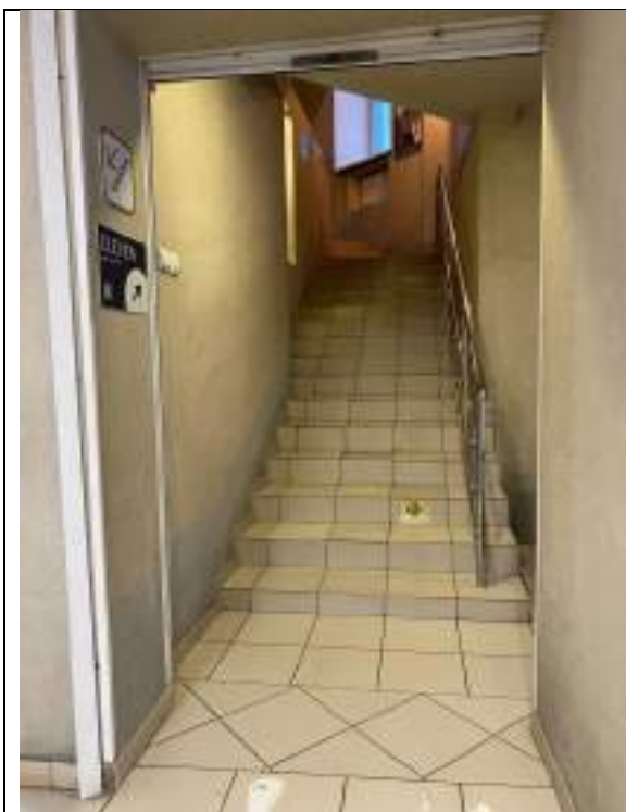
ФОТО № 13.Состояние внутренней отделки помещений Объекта оценки
