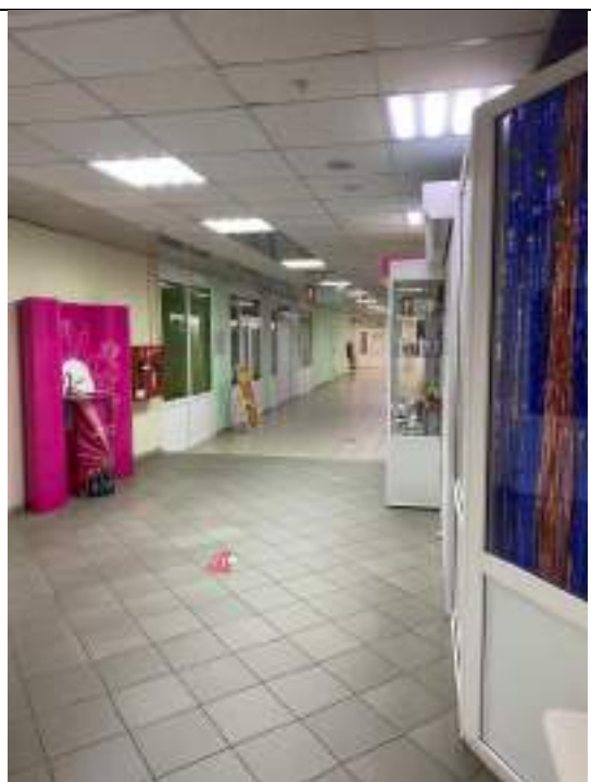
ФОТО № 22. Состояние внутренней отделки помещений Объекта оценки
