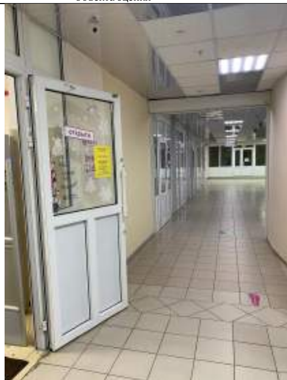
ФОТО № 19.Состояние внутренней отделки помещений Объекта оценки
