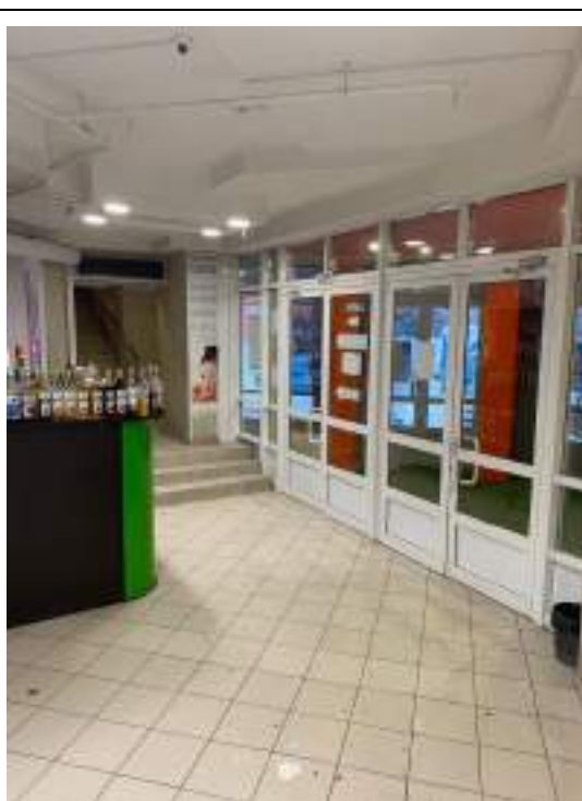
ФОТО № 14.Состояние внутренней отделки помещений Объекта оценки
