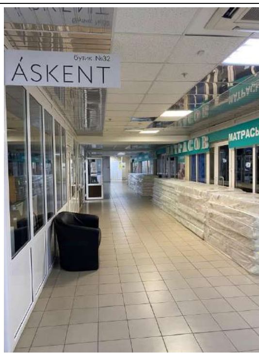
ФОТО № 10. Состояние внутренней отделки помещений Объекта оценки
