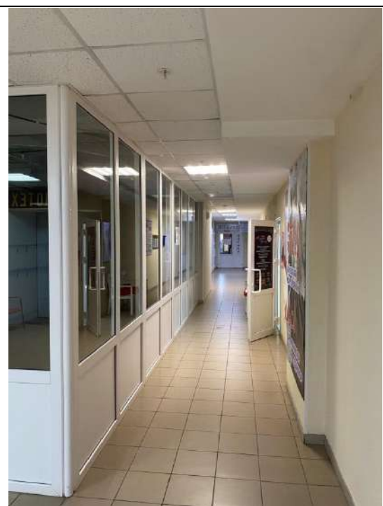
ФОТО № 14.Состояние внутренней отделки помещений Объекта оценки
