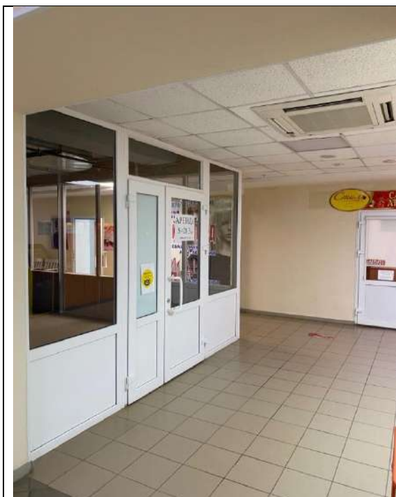
ФОТО № 13.Состояние внутренней отделки помещений Объекта оценки
