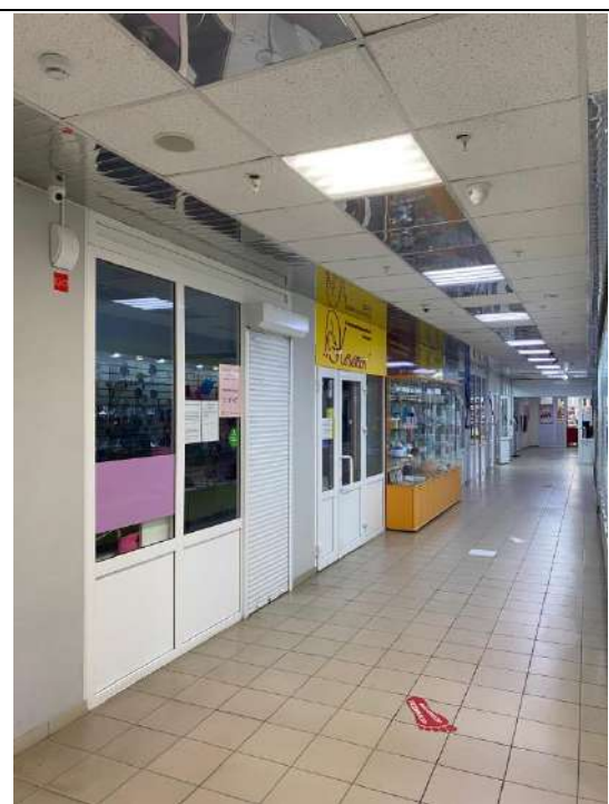
ФОТО № 6. Состояние внутренней отделки помещений Объекта оценки
