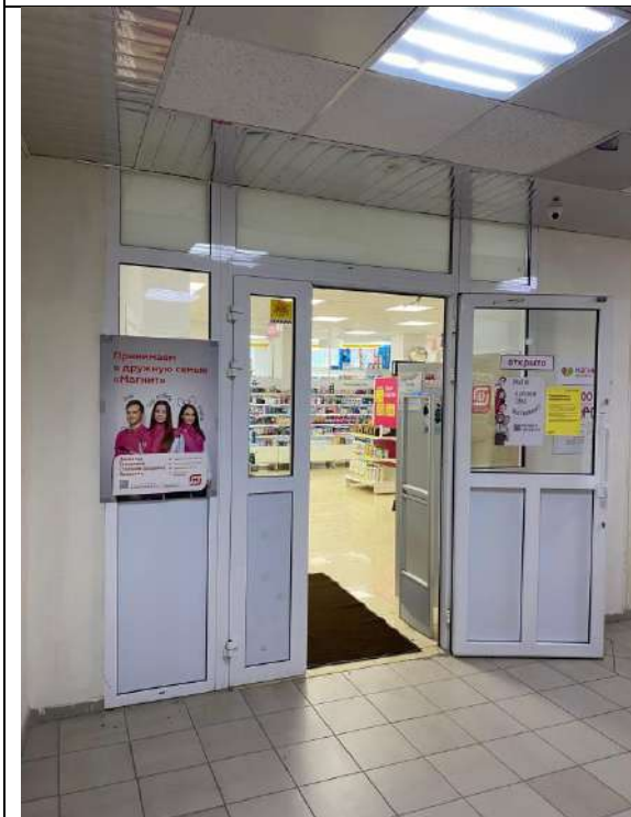
ФОТО № 3. Состояние внутренней отделки помещений Объекта оценки
