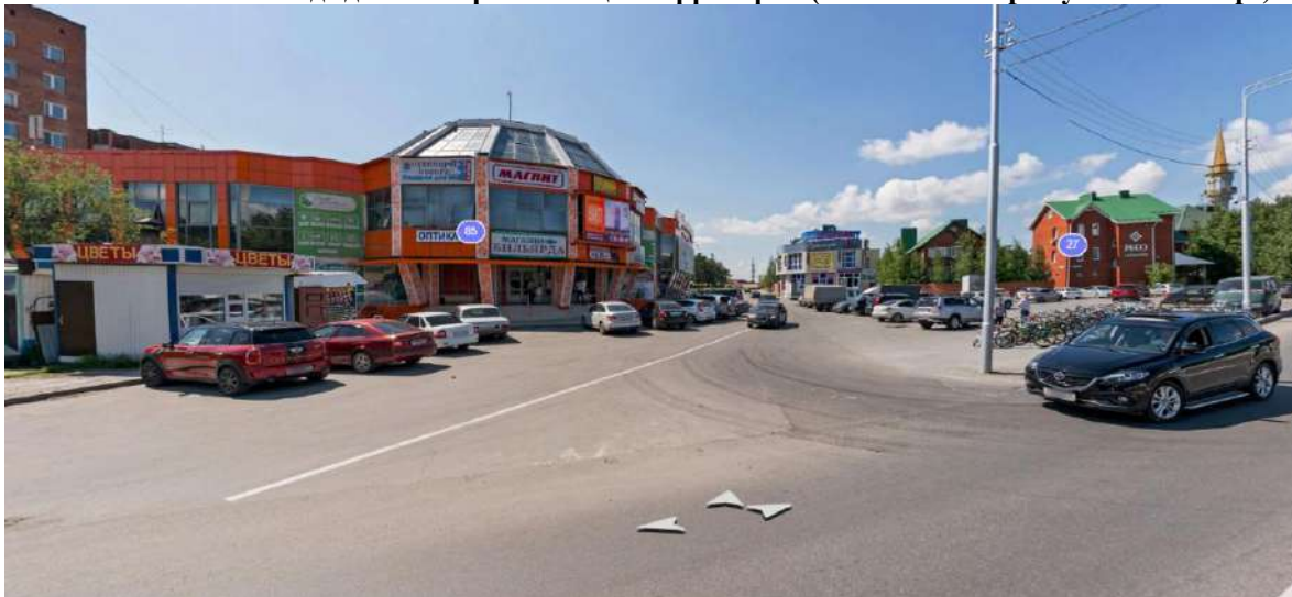
Фото 2. Внешний вид здания и прилегающая территория (источник - https://yandex.ru/maps )
