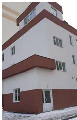
Фото 2. Вход в оцениваемое помещение
