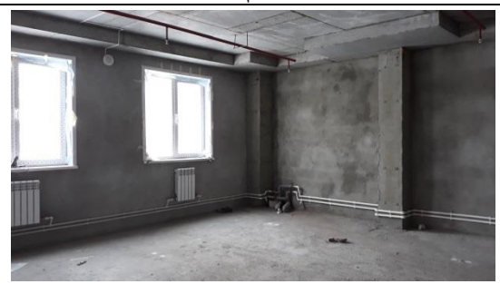
ФОТО № 4. Состояние внутренней отделки Объекта оценки
