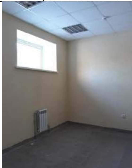
ФОТО № 3. Состояние внутренней отделки Объекта №1
