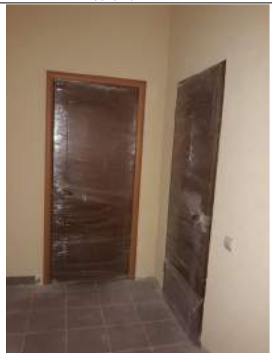
ФОТО № 4. Состояние внутренней отделки Объекта №1
