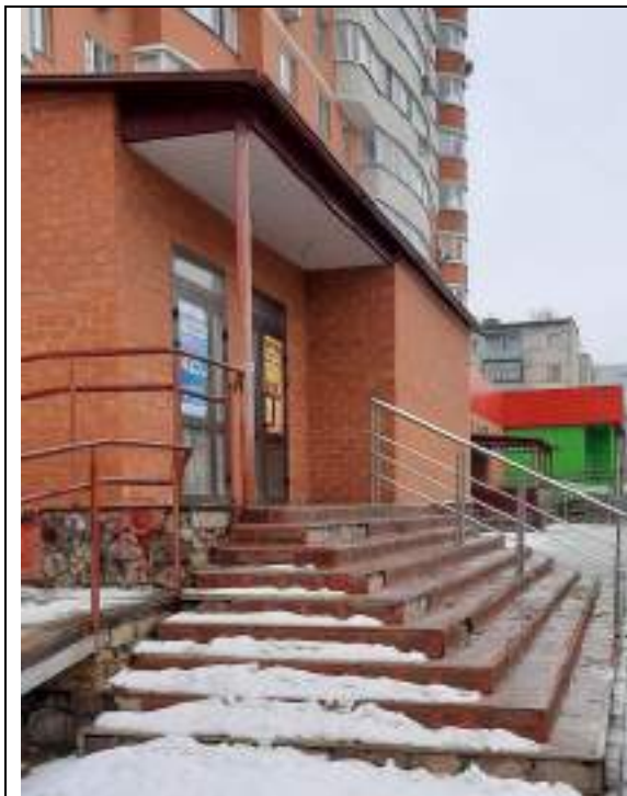
ФОТО № 1. Внешний вид здания, в котором расположены Объекты №1-№3
