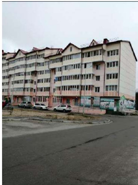
Фото 2. Внешний вид здания, в котором расположены объекты №1-4
