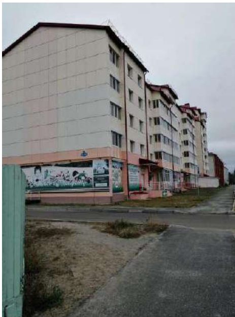
Фото 1. Внешний вид здания, в котором расположены объекты №1-4
