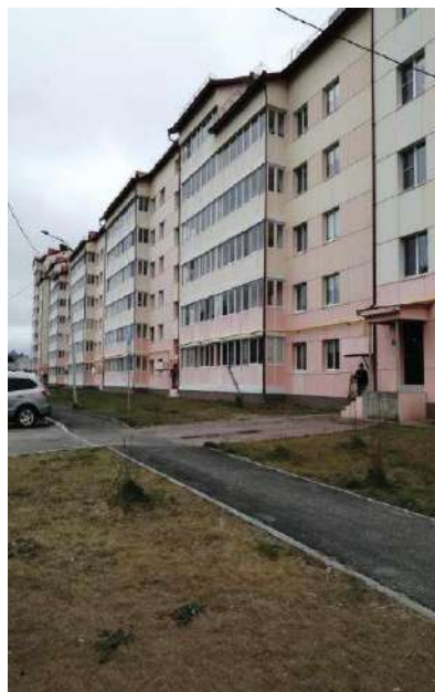
Фото 25. Внешний вид здания, в котором расположены объекты №5,6
