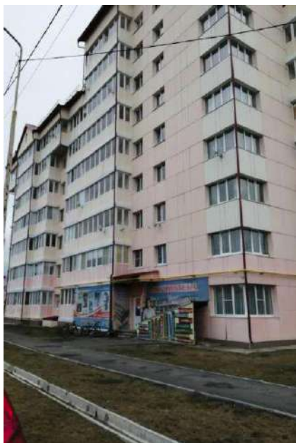
Фото 24. Внешний вид здания, в котором расположены объекты №5,6
