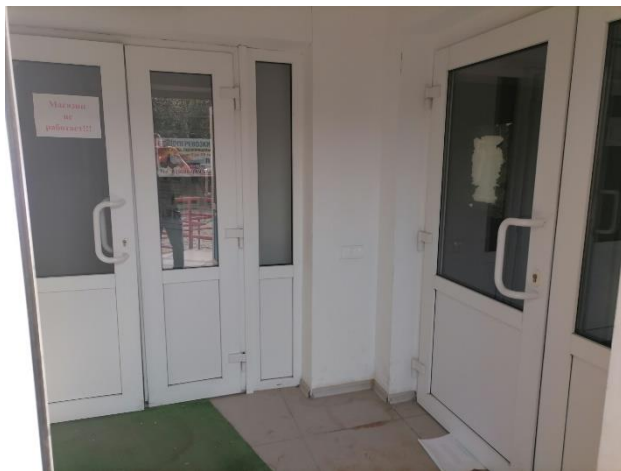
Фото 2. Внутреннее состояние помещения
