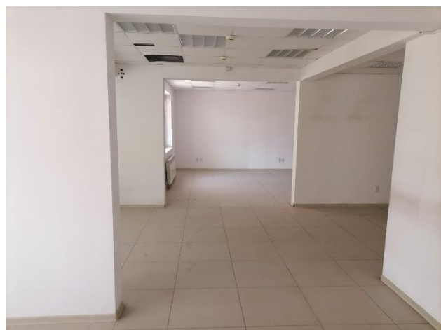
Фото 7. Внутреннее состояние помещения
