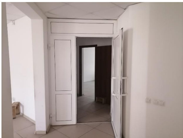
Фото 8. Внутреннее состояние помещения
