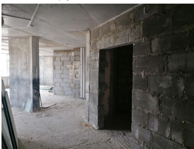
Фото 7. Внутреннее состояние помещения
