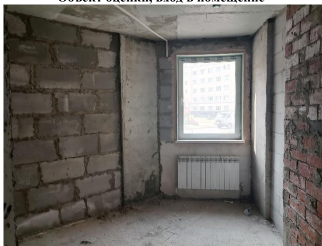
Фото 6. Внутреннее состояние помещения
