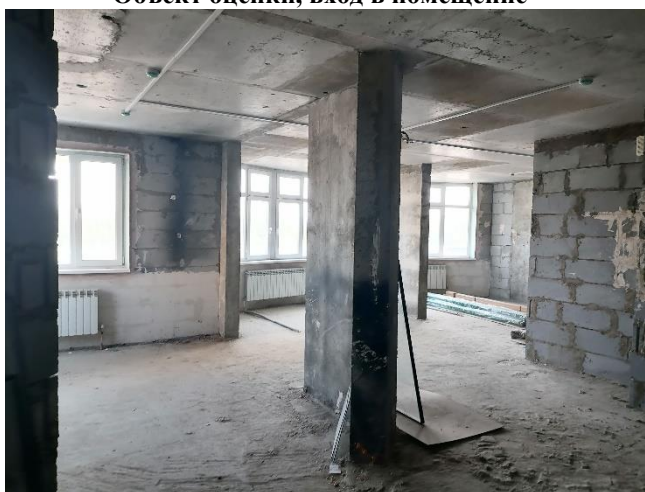
Фото 5. Внутреннее состояние помещения
