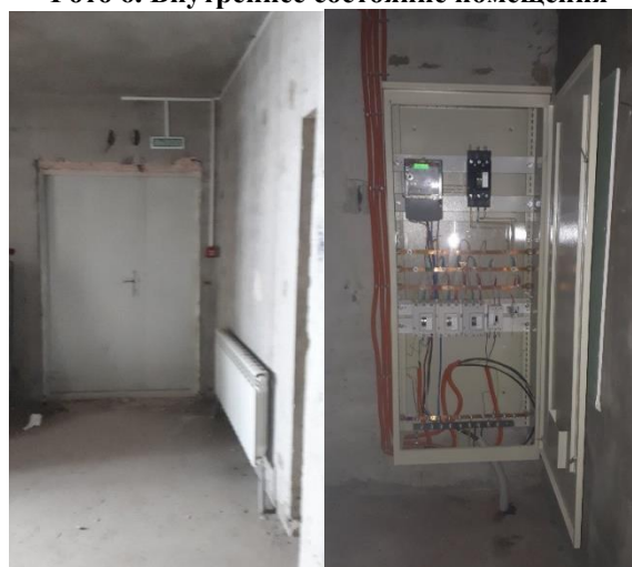
Фото 8. Внутреннее состояние помещения
