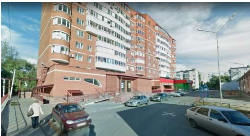
Фото 2. Внешний вид дома, в котором расположен Объект оценки 21
