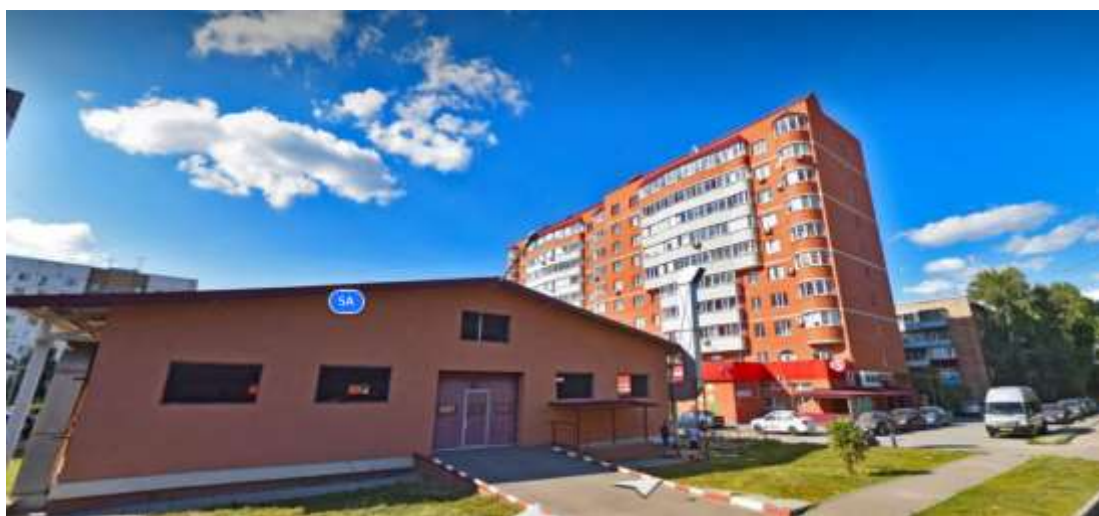
Фото 1. Внешний вид дома, в котором расположен Объект оценки 20
