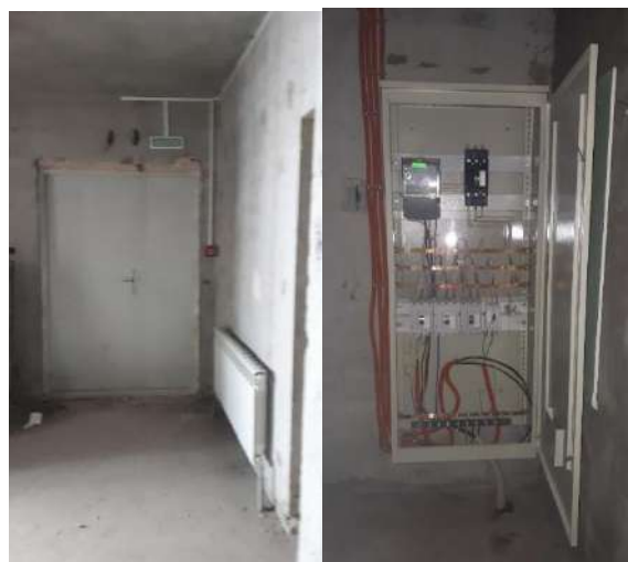
Фото 8. Внутреннее состояние помещения
