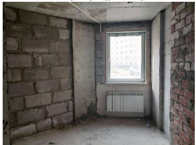
Фото 6. Внутреннее состояние помещения
