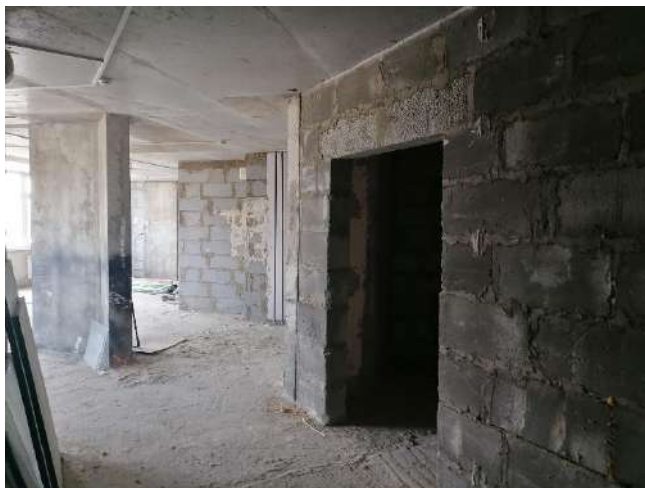
Фото 7. Внутреннее состояние помещения
