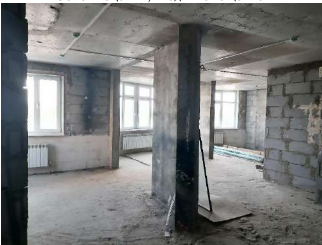
Фото 5. Внутреннее состояние помещения
