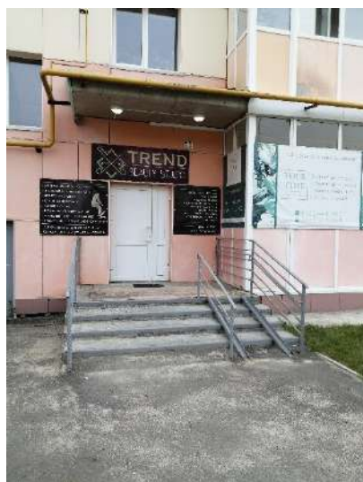
Фото 3. Вход в помещение №1
