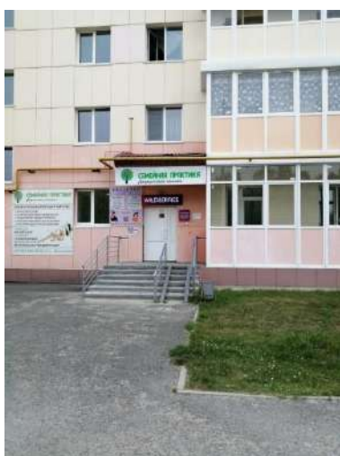
Фото 18. Вход в помещение №3
