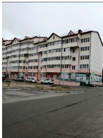
Фото 2. Внешний вид здания, в котором расположены объекты №1-4
