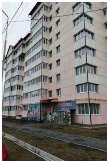
Фото 30. Внешний вид здания, в котором расположены объекты №4,5
