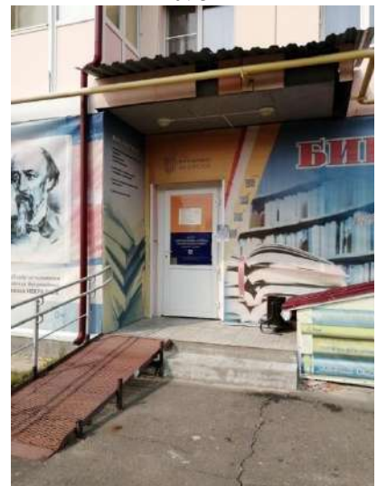
Фото 32. Вход в помещение №4
