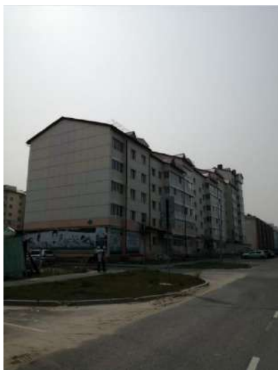
Фото 1. Внешний вид здания, в котором расположены объекты №1-3
