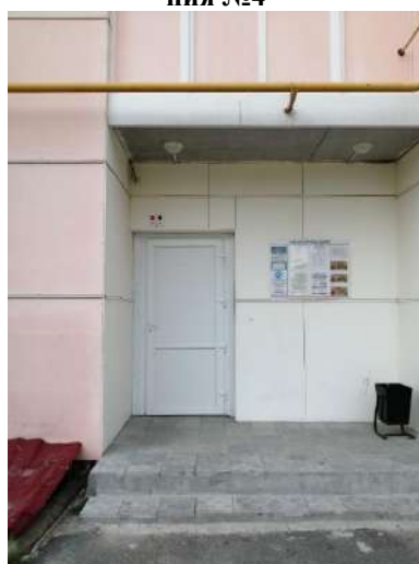
Фото 40. Вход в помещение №5
