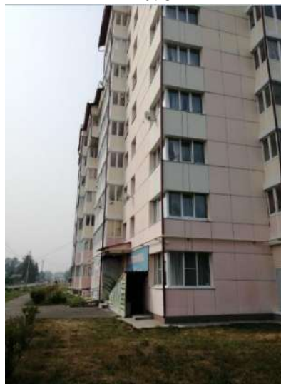
Фото 31. Внешний вид здания, в котором расположены объекты №4,5
