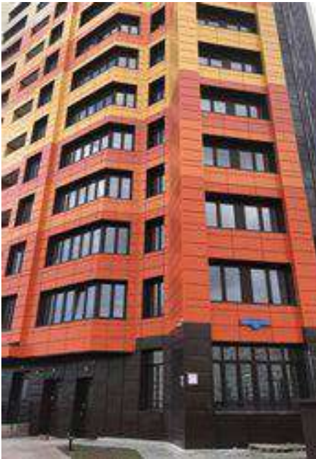
Фото 1. Внешний вид дома, в котором расположено помещение
