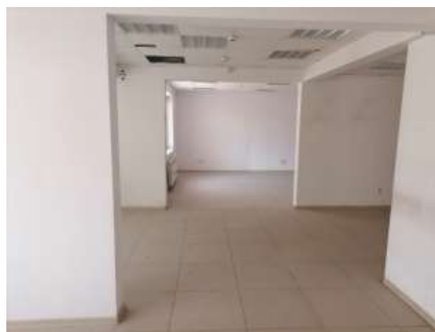
Фото 7. Внутреннее состояние помещения
