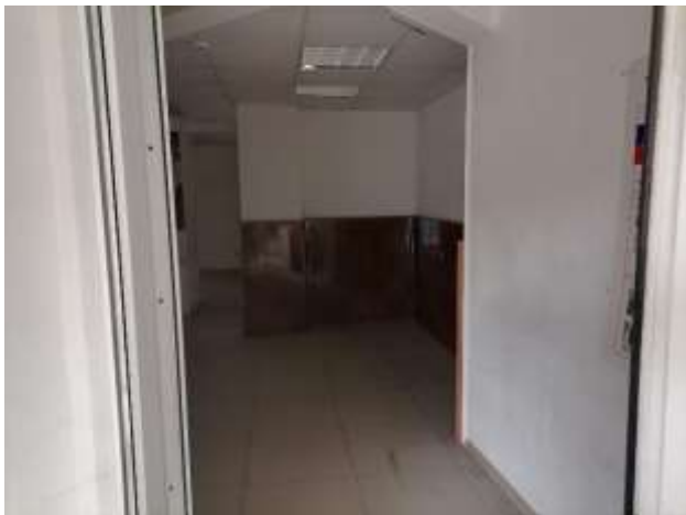
Фото 4. Внутреннее состояние помещения
