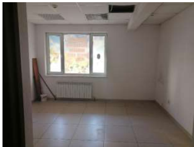
Фото 3. Внутреннее состояние помещения
