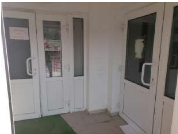
Фото 2. Внутреннее состояние помещения
