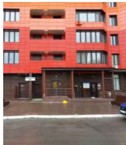
Фото 3. Вход в помещение
