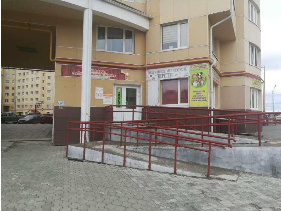
Фото 2. Вход в помещение №1
