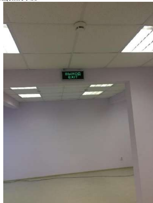
Фото 4. Внутреннее состояние помещения №1
