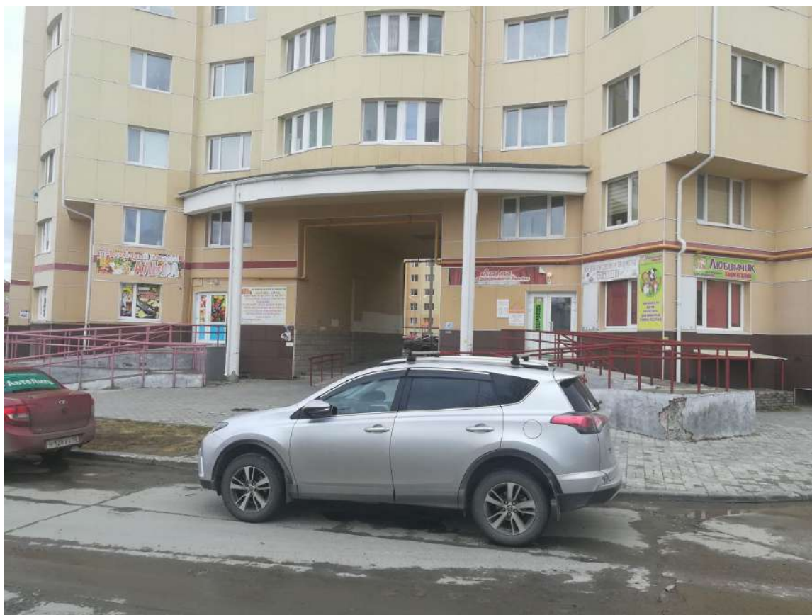
Фото 1. Внешний вид дома, в котором расположен Объект оценки (справа от арки вход в помещение №1, слева от арки вход в помещение №2)
