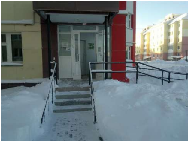
Фото 1. Вход в оцениваемое помещение
