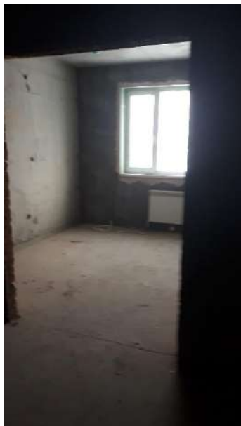
Фото 4. Внутреннее состояние помещения
