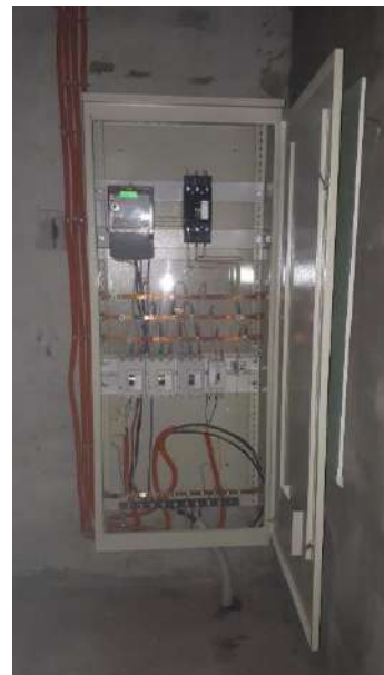
Фото 5. Внутреннее состояние помещения
