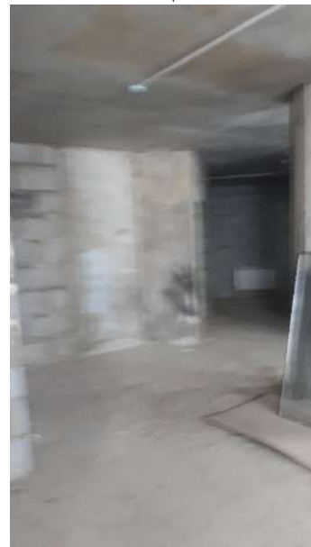
Фото 8. Внутреннее состояние помещения
