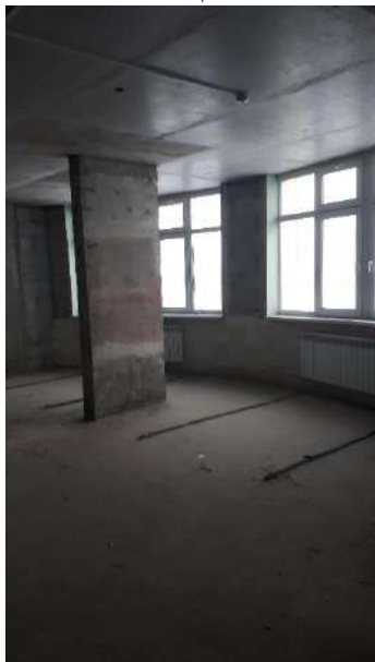
Фото 6. Внутреннее состояние помещения
