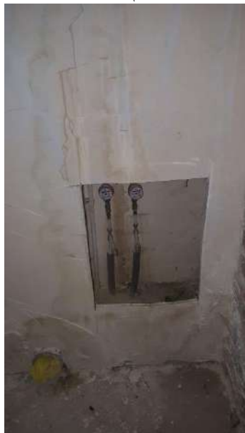
Фото 7. Внутреннее состояние помещения
