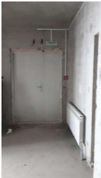
Фото 3. Внутреннее состояние помещения
