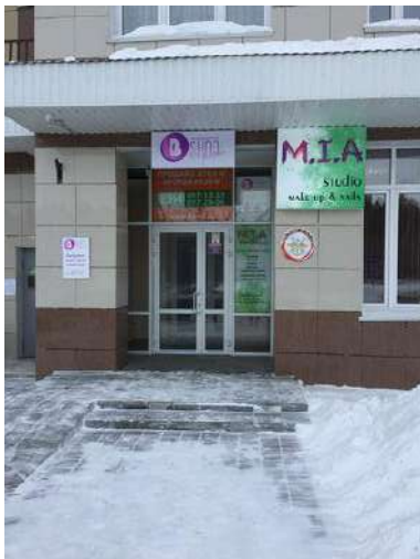
Фото 32. Вход в помещение №5 (с фасада дома)
