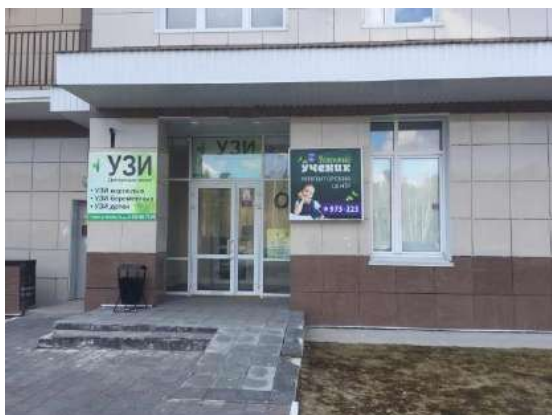
Фото 23. Вход в помещение №4 (с фасада дома)
