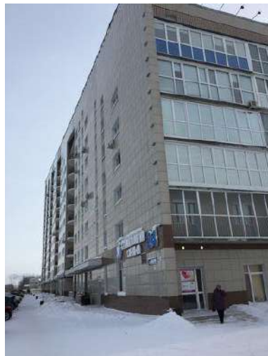
Фото 18. Вход в помещение №3
