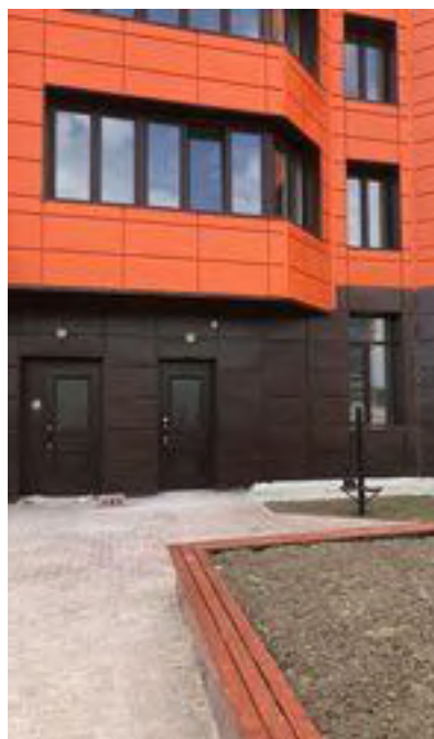
Фото 2. Вход в помещение
