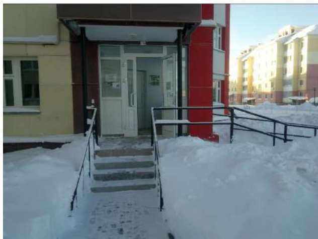
Фото 1. Вход в оцениваемое помещение
