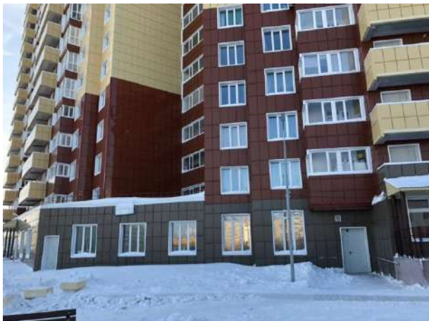
Фото 7. Вход в оцениваемое помещение общей площадью 142,6 кв. м
