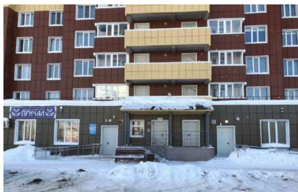
Фото 2. Вход в оцениваемое помещение общей площадью 117,9 кв. м
