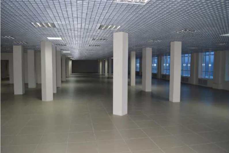
Фото 8. Внутренние помещения оцениваемого объекта
