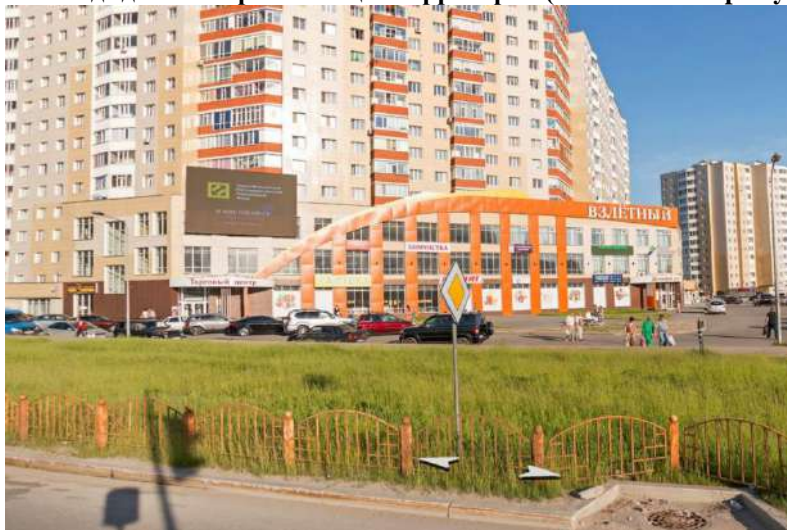
Фото 2. Внешний вид здания и прилегающая территория (источник - https://yandex.ru/maps )
