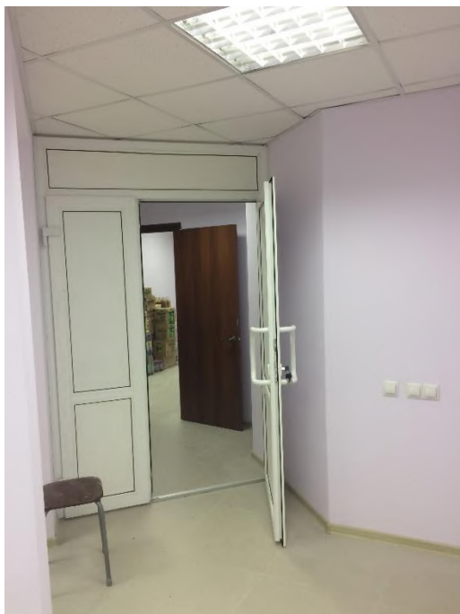
Фото 5. Внутреннее состояние помещения №1
