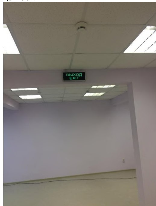
Фото 4. Внутреннее состояние помещения №1
