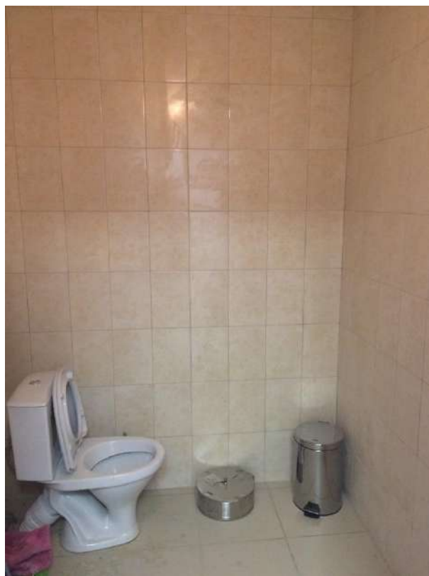
Фото 6. Внутреннее состояние помещения
