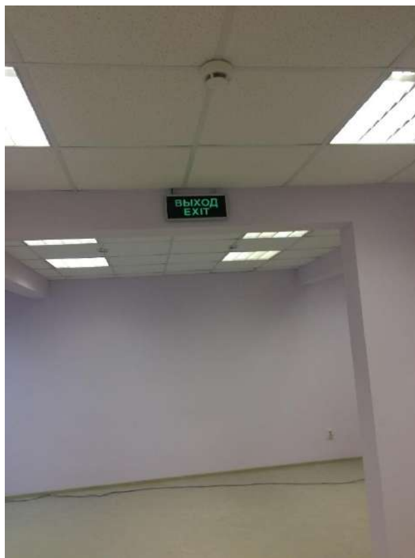
Фото 4. Внутреннее состояние помещения
