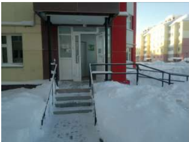
Фото 1. Вход в оцениваемое помещение
