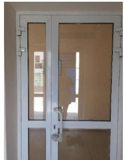
Фото 4. Вход в помещение №1 (правый торец дома)
