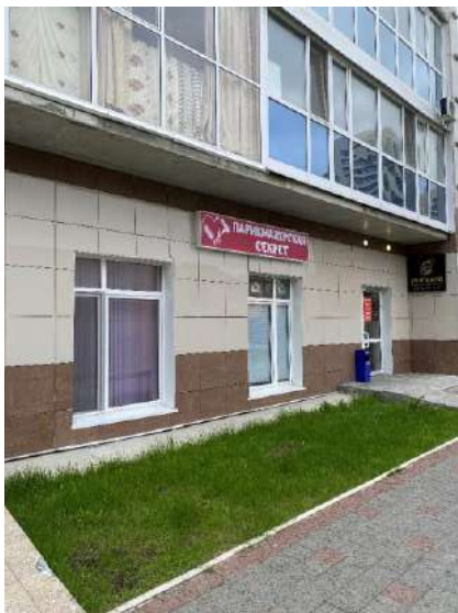
Фото 2. Вход в помещение №1 (правый торец дома)
