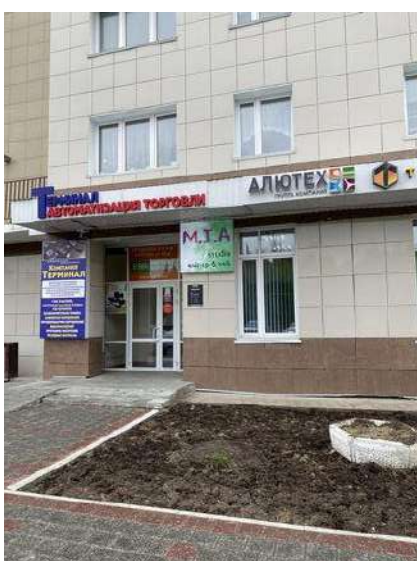
Фото 20. Вход в помещение №3 (с фасада дома)
