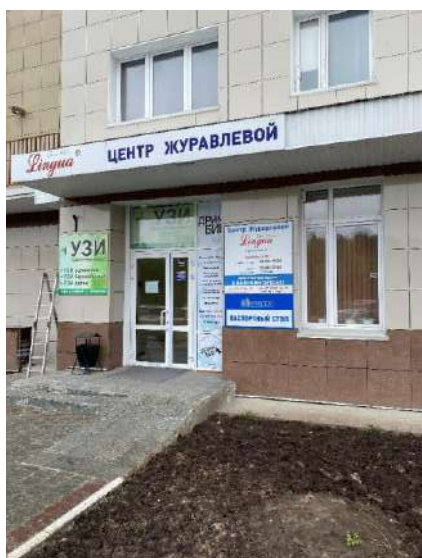
Фото 11. Вход в помещение №2 (с фасада дома)
