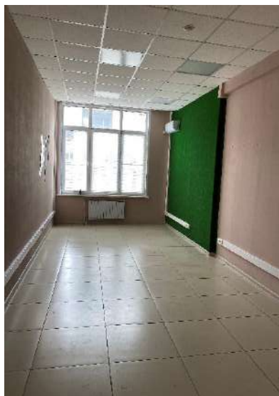
Фото 15. Состояние помеще- ния №2
