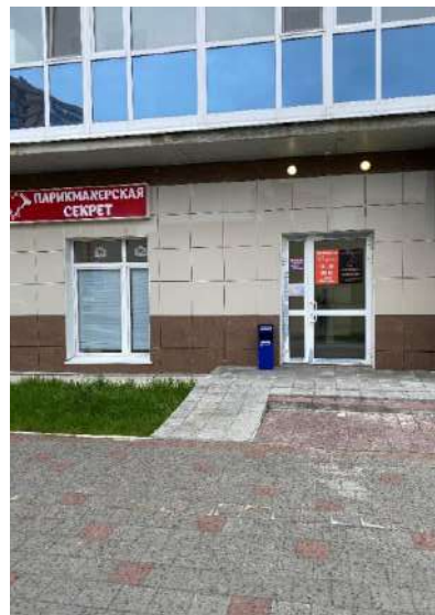
Фото 3. Вход в помещение №1 (правый торец дома)
