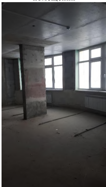
Фото 6. Внутреннее состояние помещения
