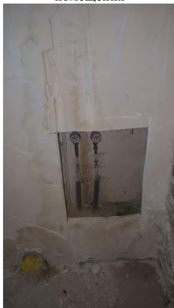
Фото 7. Внутреннее состояние помещения
