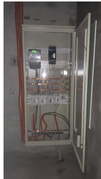
Фото 5. Внутреннее состояние помещения
