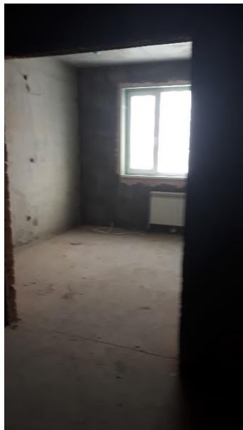
Фото 4. Внутреннее состояние помещения
