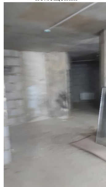
Фото 8. Внутреннее состояние помещения
