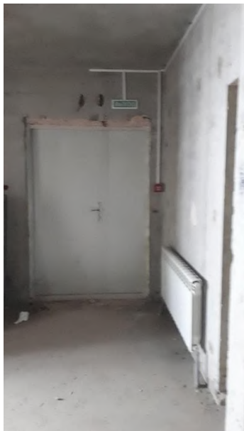
Фото 3. Внутреннее состояние помещения
