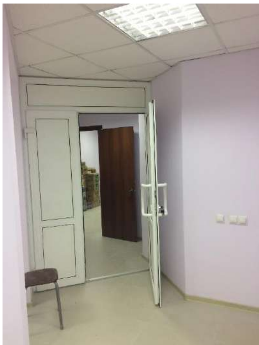
Фото 5. Внутреннее состояние помещения №1
