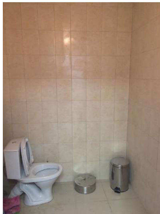
Фото 6. Внутреннее состояние помещения №1
