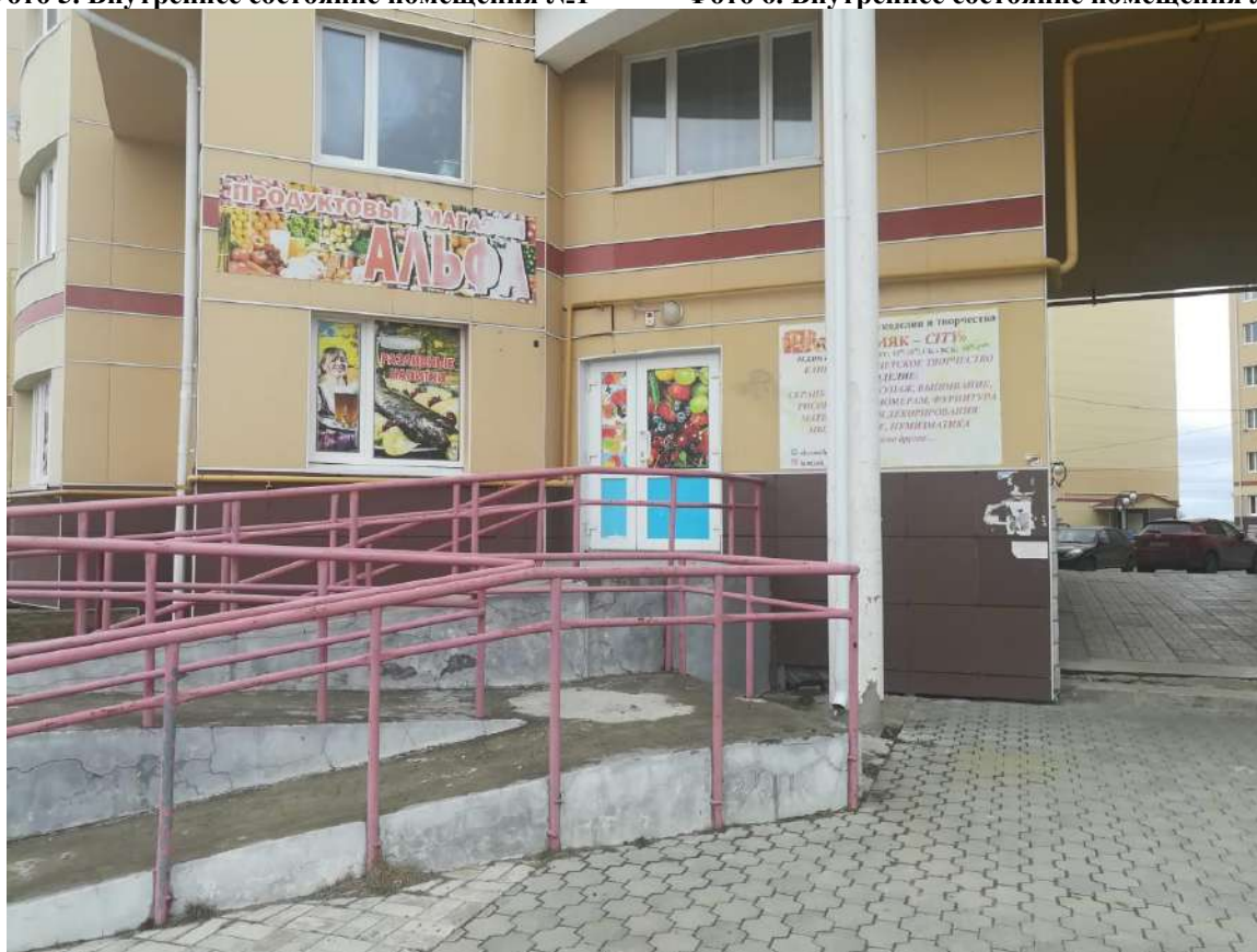
Фото 7. Вход в помещение №2
