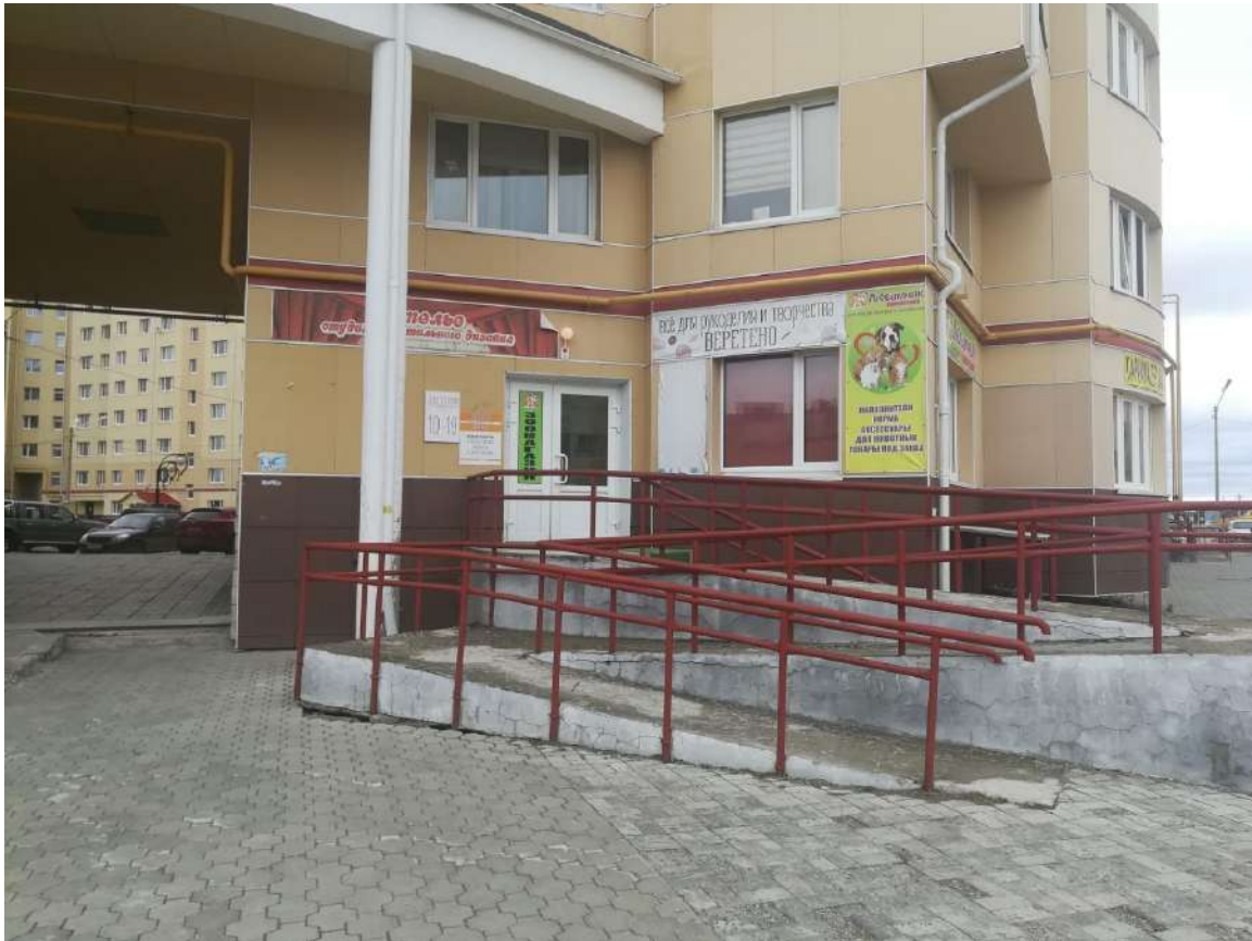
Фото 2. Вход в помещение №1
