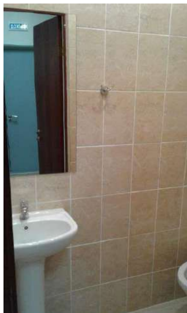
Фото 13. Состояние помеще- ния №2
