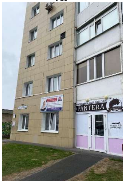
Фото 12. Вход в помещение №2
