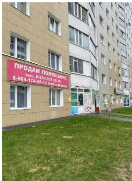
Фото 19. Вход в помещение №3
