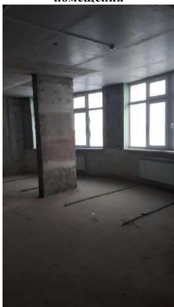
Фото 6. Внутреннее состояние помещения
