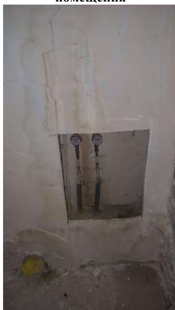
Фото 7. Внутреннее состояние помещения
