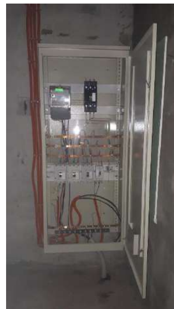
Фото 5. Внутреннее состояние помещения
