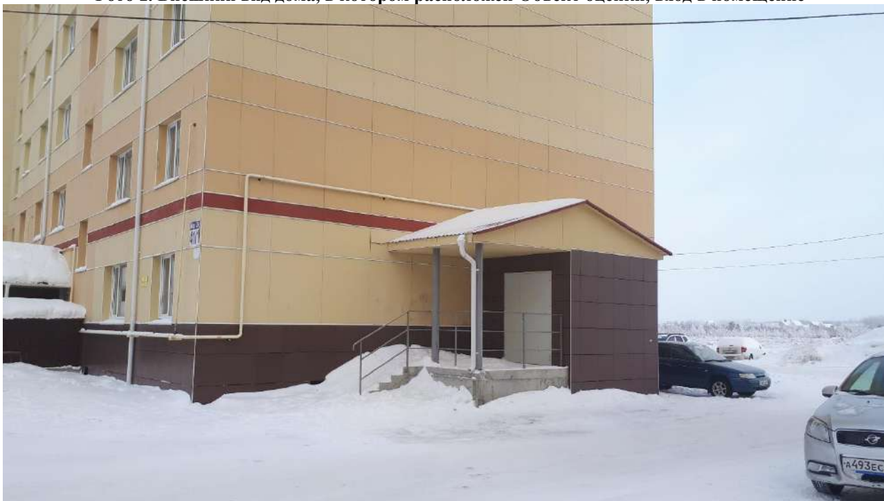
Фото 2. Внешний вид дома, в котором расположен Объект оценки
