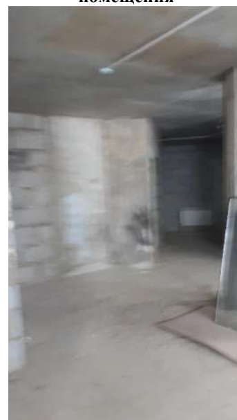
Фото 8. Внутреннее состояние помещения
