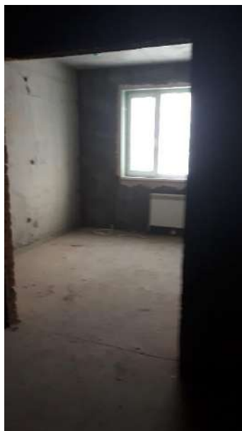
Фото 4. Внутреннее состояние помещения
