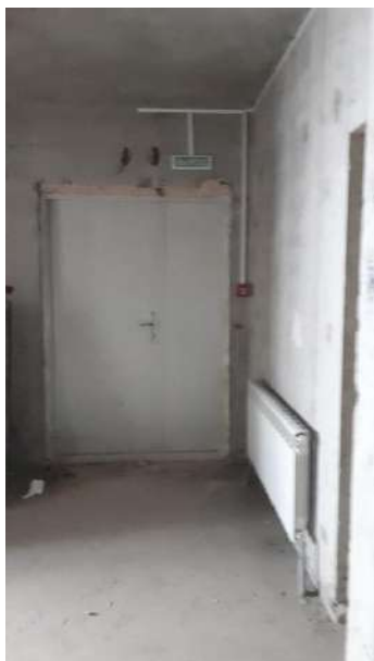
Фото 3. Внутреннее состояние помещения
