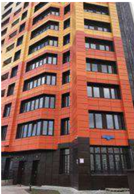
Фото 1. Внешний вид дома, в котором расположено помещение
