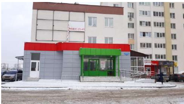
Фото 1. Внешний вид дома, в котором расположен Объект оценки
