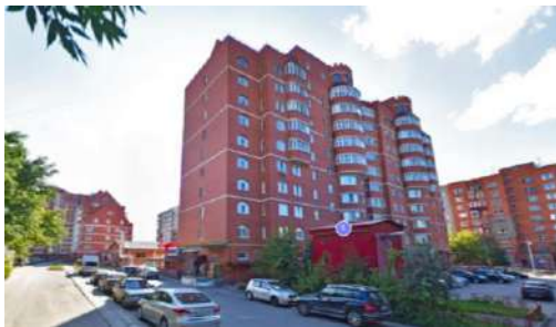
Фото 3. Внешний вид дома, в котором расположен Объект оценки 14
