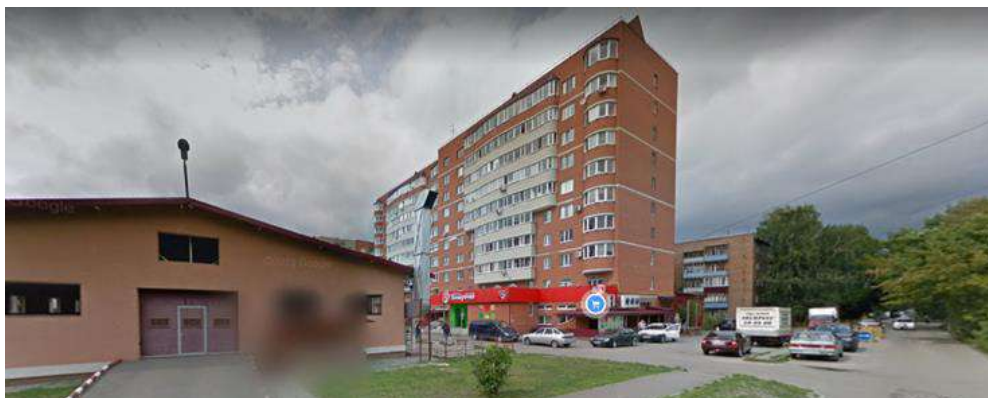
Фото 1. Внешний вид дома, в котором расположен Объект оценки 12
