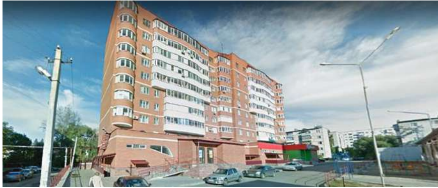
Фото 2. Внешний вид дома, в котором расположен Объект оценки 13
