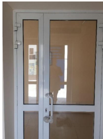
Фото 4. Вход в помещение №1 (правый торец дома)
