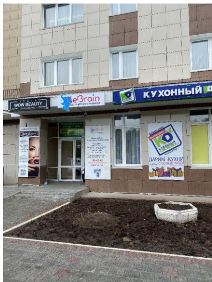
Фото 11. Вход в помещение №2 (с фасада дома)
