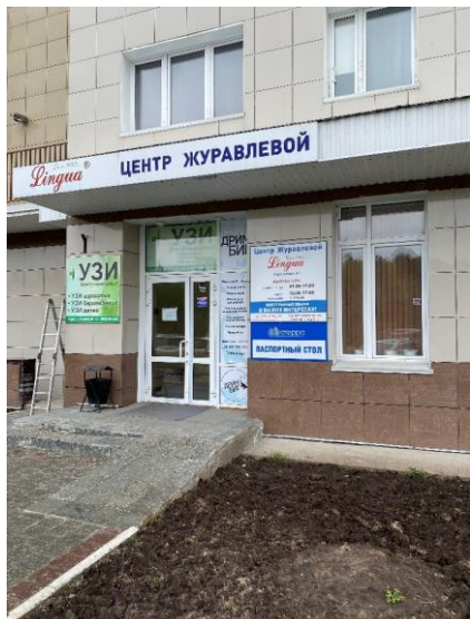
Фото 20. Вход в помещение №3 (с фасада дома)
