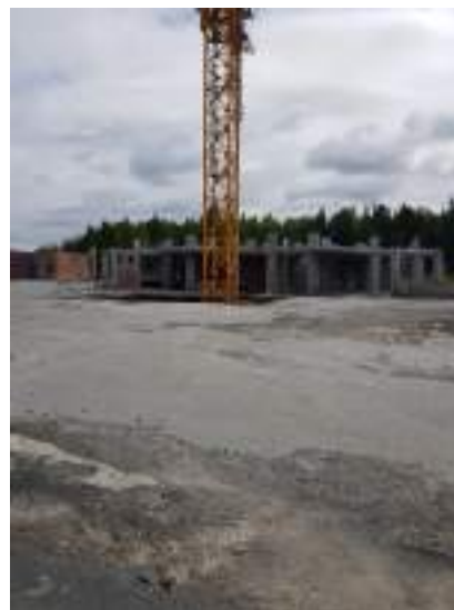
Фото 2. Состояние строительной готовности корпуса № 7
