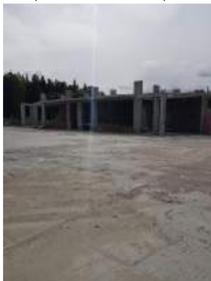
Фото 1. Состояние строительной готовности корпуса № 7
