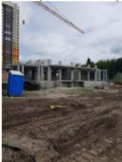
Фото 3. Состояние строительной готовности корпуса № 7
