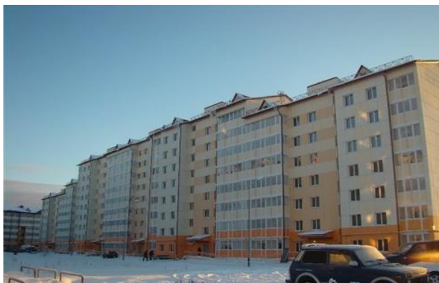
Фото 1. Жилой дом, в котором расположены оцениваемые квартиры
