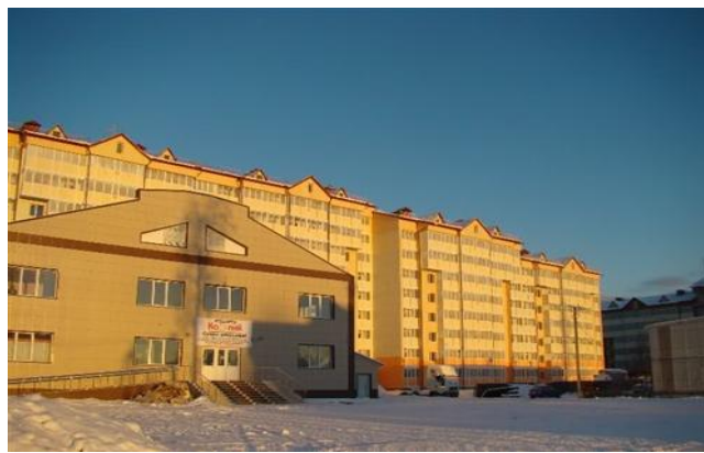
Фото 2. Жилой дом, в котором расположены оцениваемые квартиры
