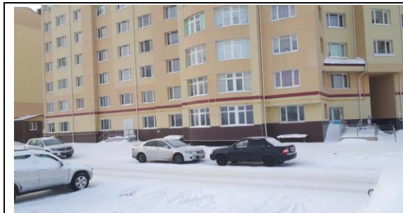
ФОТО № 1. Внешний вид дома, в котором расположен Объект оценки
