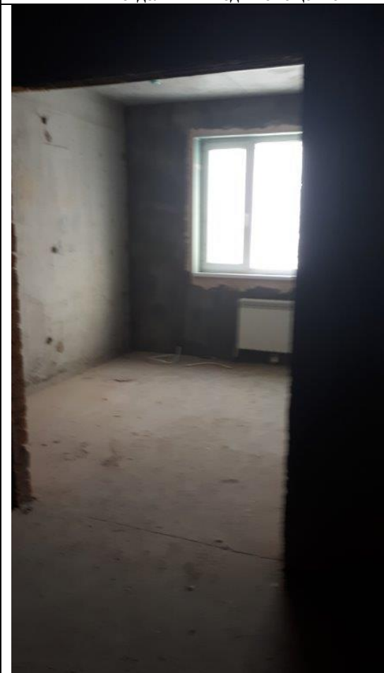
ФОТО № 4. Состояние внутренней отделки помещений Объекта оценки
