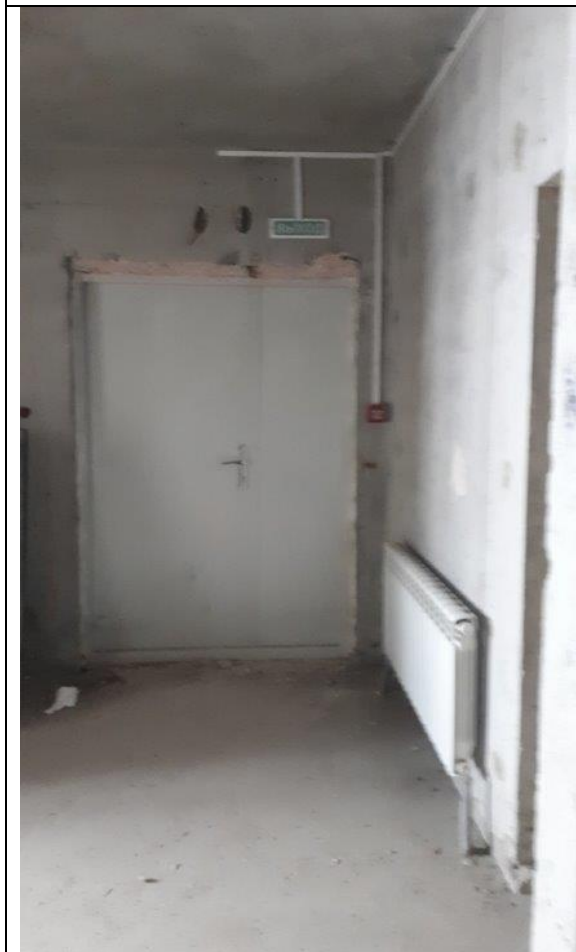
ФОТО № 3. Состояние внутренней отделки помещений Объекта оценки
