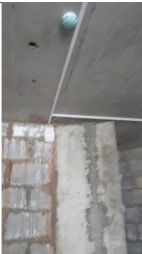
ФОТО № 9. Состояние внутренней отделки помещений Объекта оценки
