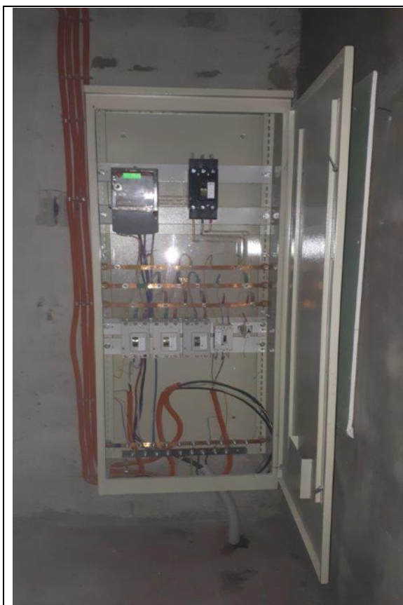
ФОТО № 5. Состояние внутренней отделки помещений Объекта оценки
