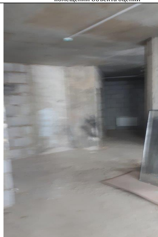
ФОТО № 8. Состояние внутренней отделки помещений Объекта оценки
