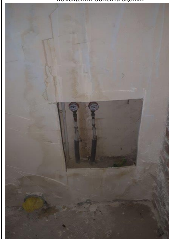
ФОТО № 7. Состояние внутренней отделки помещений Объекта оценки
