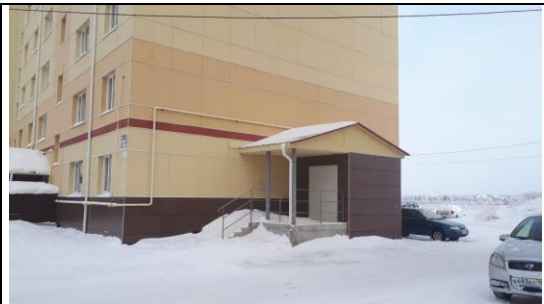
ФОТО № 2. Внешний вид дома, в котором расположен Объект оценки, отдельный вход в помещение
