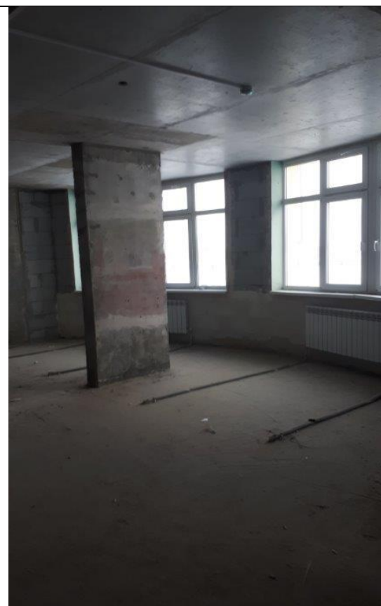
ФОТО № 6. Состояние внутренней отделки помещений Объекта оценки
