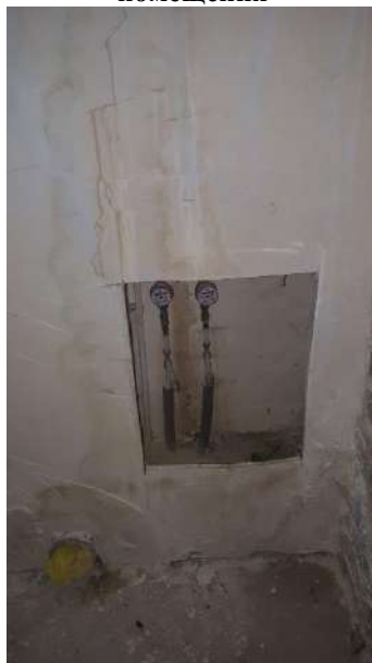
Фото 7. Внутреннее состояние помещения
