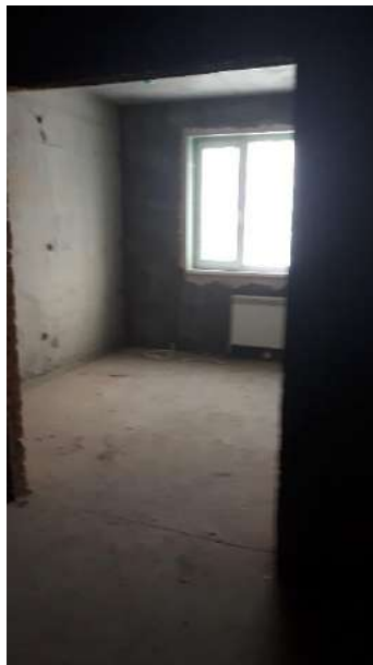
Фото 4. Внутреннее состояние помещения
