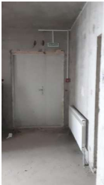
Фото 3. Внутреннее состояние помещения
