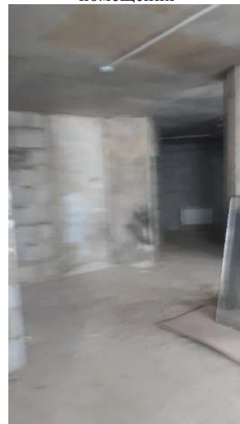
Фото 8. Внутреннее состояние помещения
