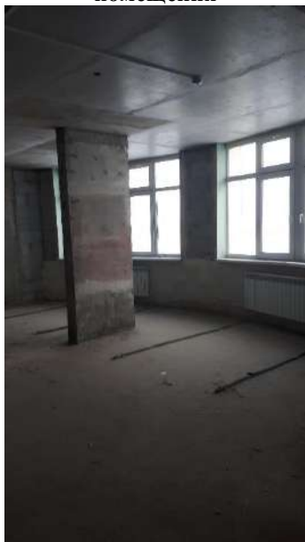
Фото 6. Внутреннее состояние помещения
