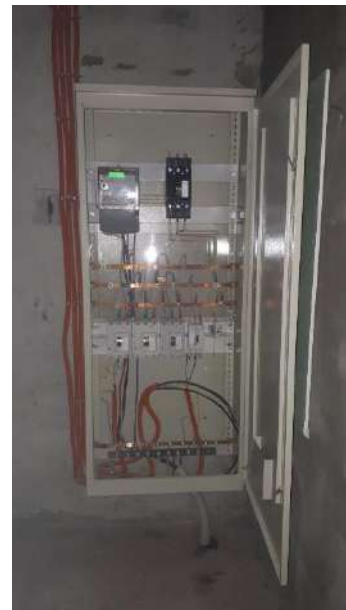
Фото 5. Внутреннее состояние помещения
