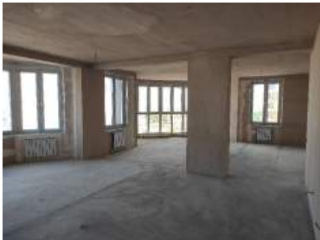
Фото 23. Квартира с кадастровым номером 86:10:0101025:1687
