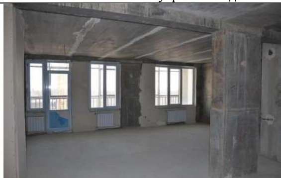
ФОТО № 20. Состояние внутренней отделки
