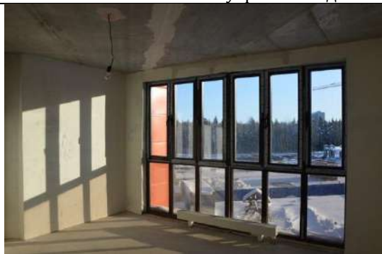
ФОТО № 15. Состояние внутренней отделки
