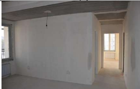
ФОТО № 12. Состояние внутренней отделки
