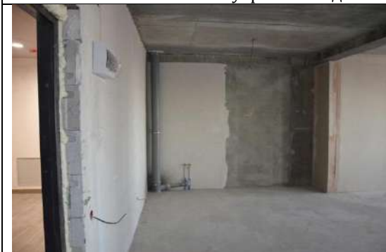
ФОТО № 19. Состояние внутренней отделки
