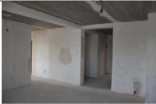
ФОТО № 11. Состояние внутренней отделки
