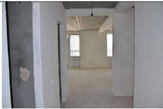
ФОТО № 9. Состояние внутренней отделки
