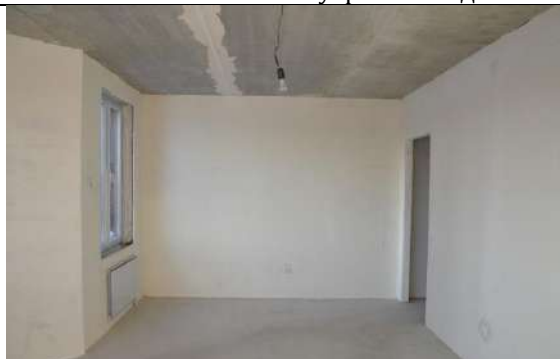
ФОТО № 16. Состояние внутренней отделки
