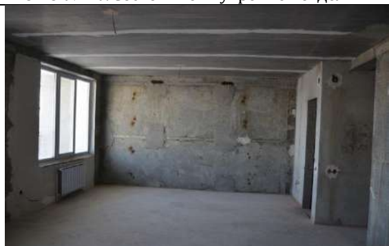
ФОТО № 22. Состояние внутренней отделки
