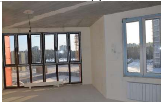
ФОТО № 14. Состояние внутренней отделки
