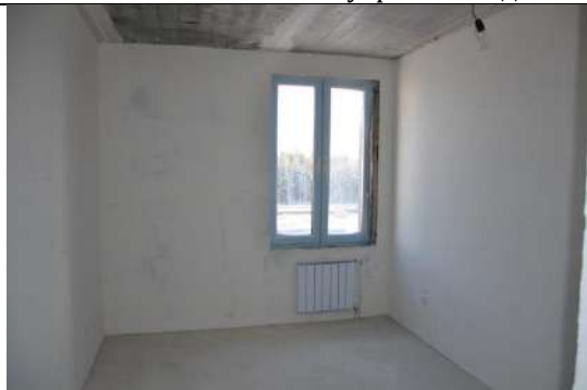
ФОТО № 13. Состояние внутренней отделки
