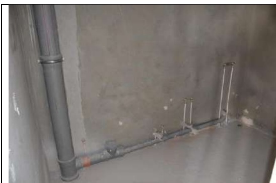
ФОТО № 17. Состояние внутренней отделки
