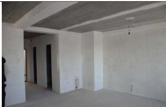
ФОТО № 10. Состояние внутренней отделки
