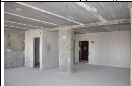
ФОТО № 21. Состояние внутренней отделки
