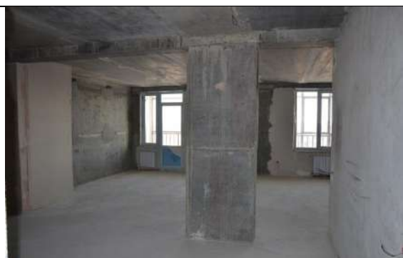
ФОТО № 18. Состояние внутренней отделки
