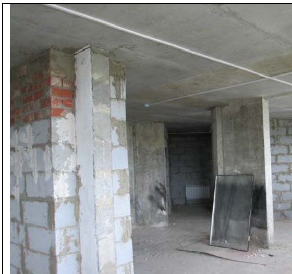
ФОТО № 7. Состояние внутренней отделки помещений Объекта оценки
