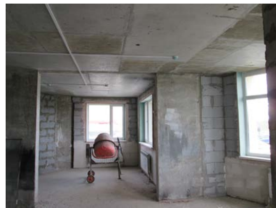
ФОТО № 8. Состояние внутренней отделки помещений Объекта оценки
