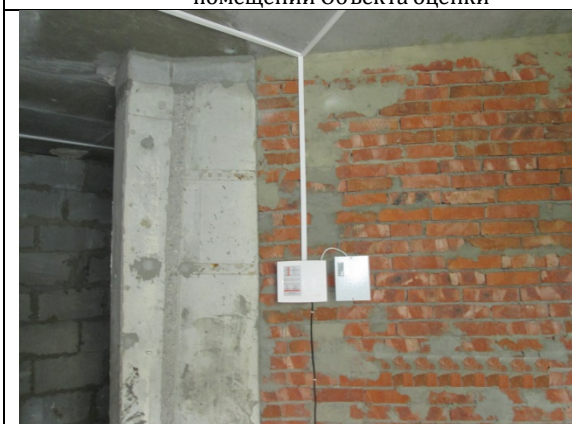
ФОТО № 9. Состояние внутренней отделки помещений Объекта оценки
