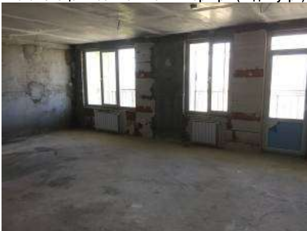
Фото 17. Оцениваемые 2- комн. квартиры (вид внутри)
