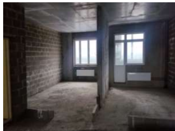
Фото. 4. Внутренний вид жилых помещений (квартир)
