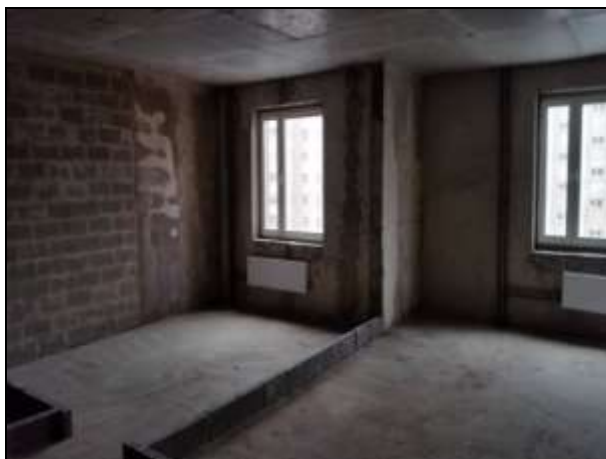
Фото. 3. Внутренний вид жилых помещений (квартир)
