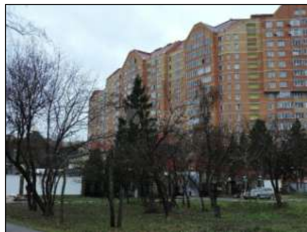
Фото. 2. Внешний вид жилого дома
