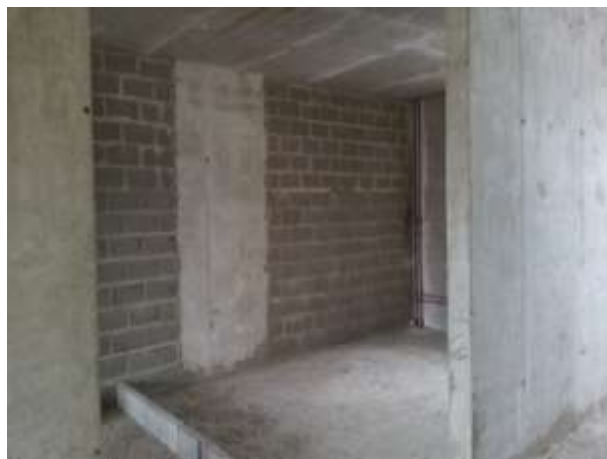
Фото. 6. Внутренний вид жилых помещений (квартир)
