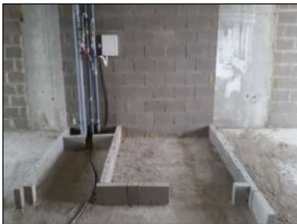
Фото. 5. Внутренний вид жилых помещений (квартир)
