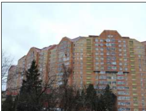
Фото. 1. Внешний вид жилого дома
