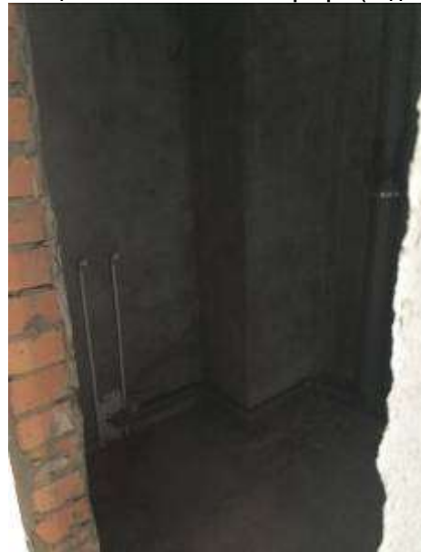
Фото 38. Оцениваемые 2- комн. квартиры (вид внутри)
