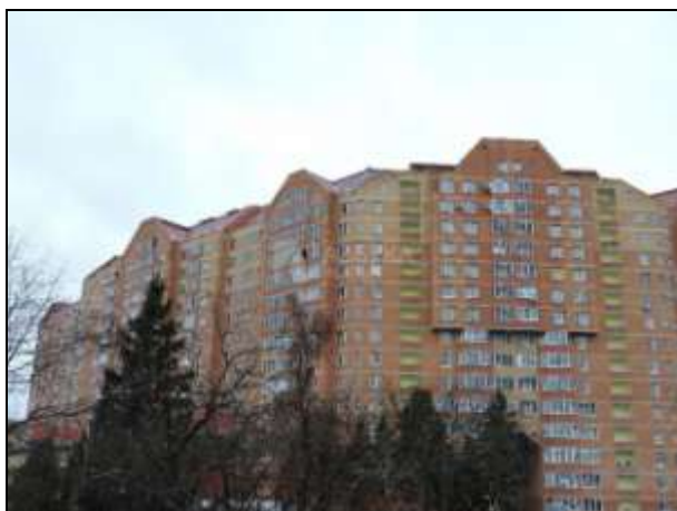
Фото 1. Внешний вид жилого дома
