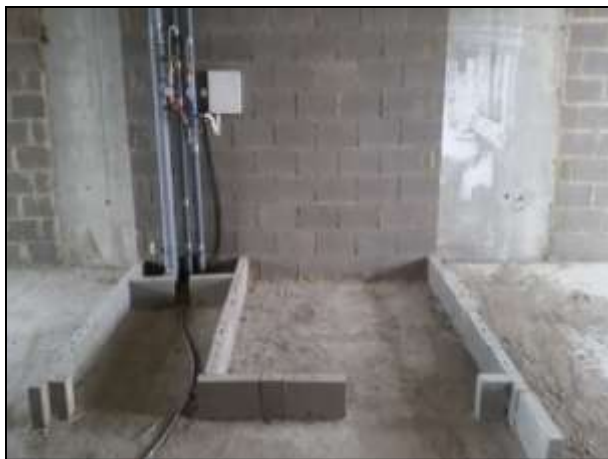
Фото. 5. Внутренний вид жилых помещений (квартир)
