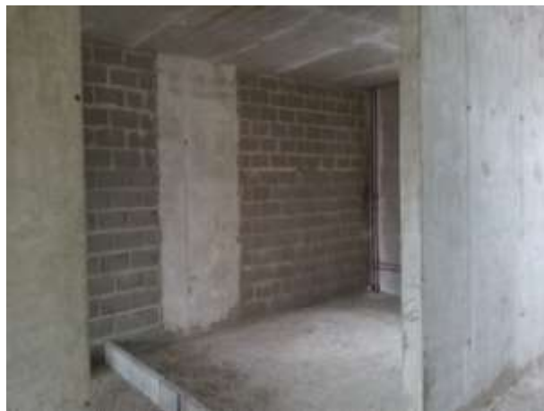
Фото. 6. Внутренний вид жилых помещений (квартир)
