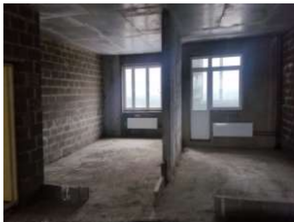
Фото. 4. Внутренний вид жилых помещений (квартир)
