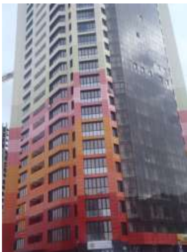
Фото 3. Внешний вид дома
