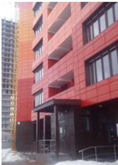
Фото 1. Внешний вид дома
