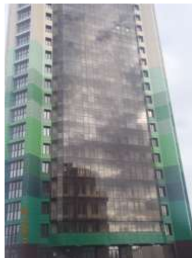
Фото 4. Внешний вид дома
