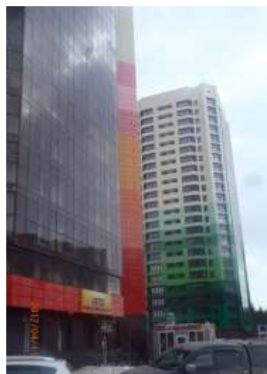
Фото 2. Внешний вид дома
