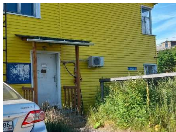
Фото. 2. Жилой дом по адресу: г. Ханты-Мансийск, ул. Чехова, д. 62
