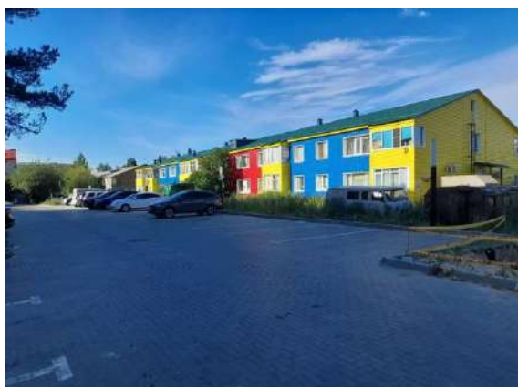
Фото. 1. Жилой дом по адресу: г. Ханты-Мансийск, ул. Чехова, д. 62
