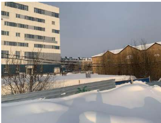
Фото 7. Общий вид объекта незавершенного строительства кадастровый (или условный) номер: 86:12:0101059:30
