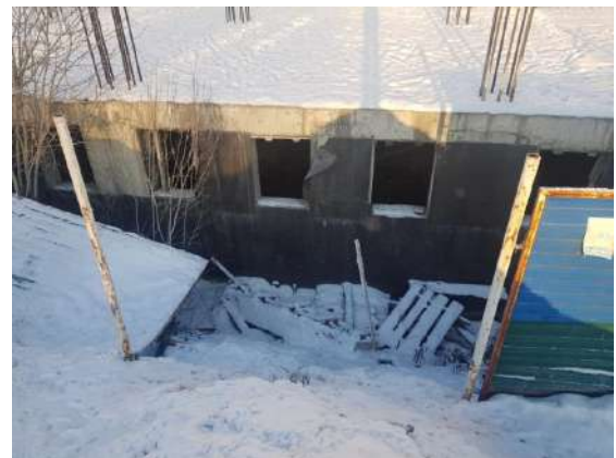
Фото 8. Общий вид объекта незавершенного строительства кадастровый (или условный) номер: 86:12:0101059:30
