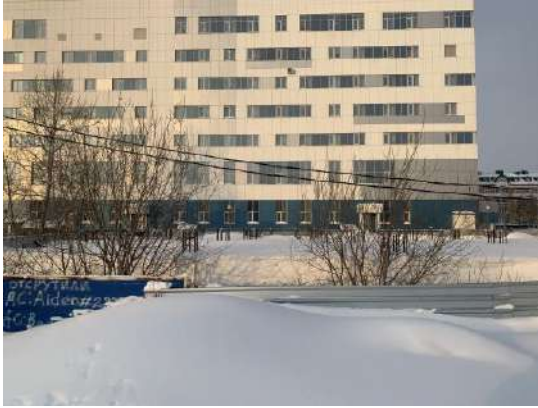
Фото 5. Общий вид объекта незавершенного строительства кадастровый (или условный) номер: 86:12:0101059:30
