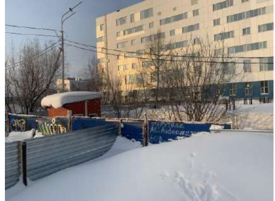
Фото 6. Общий вид объекта незавершенного строительства кадастровый (или условный) номер: 86:12:0101059:30
